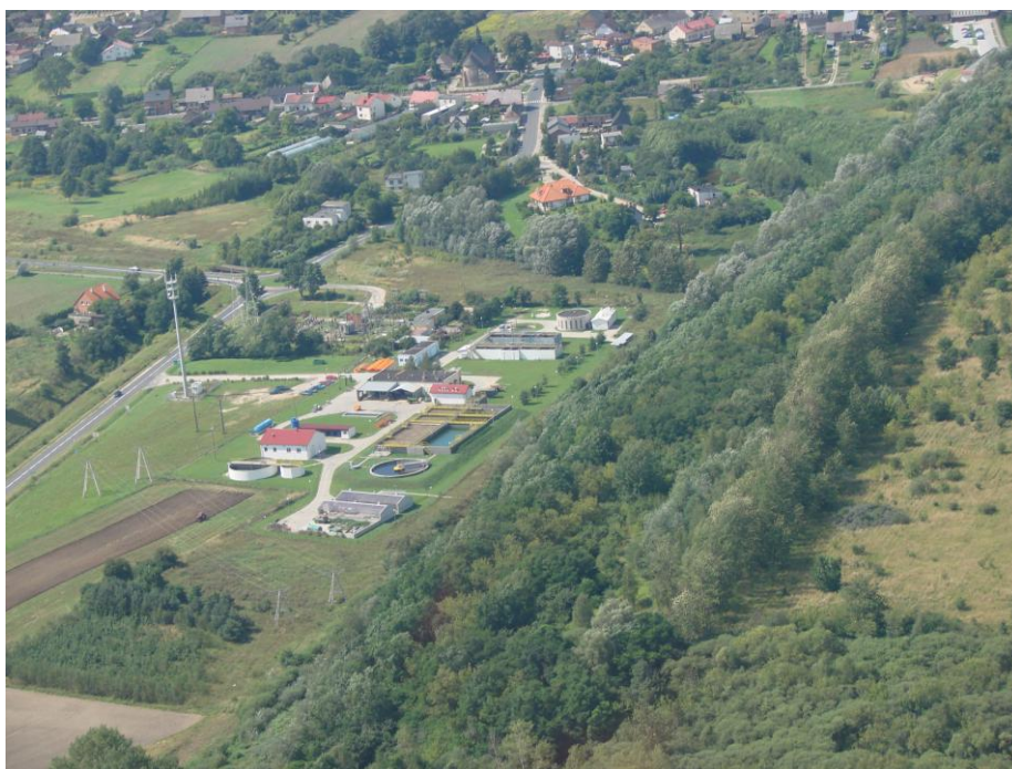
Fotografia 4.2. Oczyszczalnia ścieków w Kazimierzy Biskupim, zdjęcie z lotu ptaka (źródło: UG)
