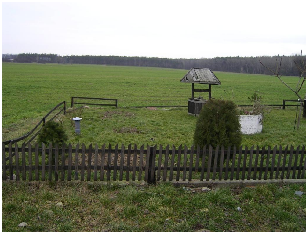
Fotografia 4.1. Przydomowa oczyszczalnia ścieków w miejscowości Daninów (źródło: UG)
